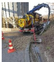
Le collecteur d'eaux claires à la route du Moulin de la Vaux était complètement bouché par le calcaire. La configuration de ce collecteur ne permettait pas un piquage pour y remédier, et des travaux de correction ont dû être préalablement entrepris.
